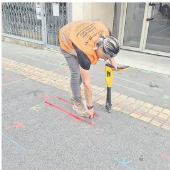
Type de réseau, localisation, profondeur, certitude de la mesure... Les techniciens-géomètres sont méticuleux dans leur détection des réseaux souterrains. (Photos NR, Bastien David)
