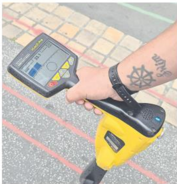
Avec un détecteur d'ondes électromagnétiques, Jérémy Chanal repère les réseaux électriques ou téléphoniques.
